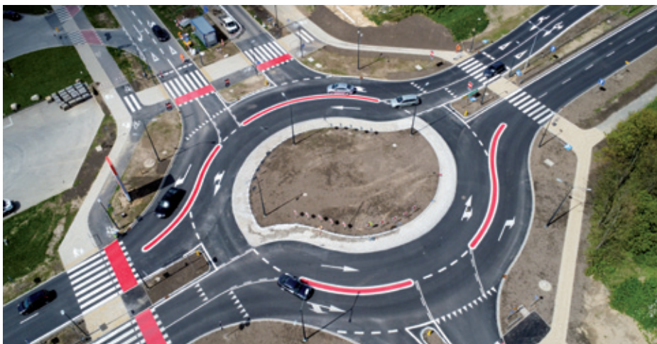
▲ Rozbudowa skrzyżowania drogi wojewódzkiej nr 333 z aleją Jana Pawła II w Polkowicach. Fot. UM Polkowice
