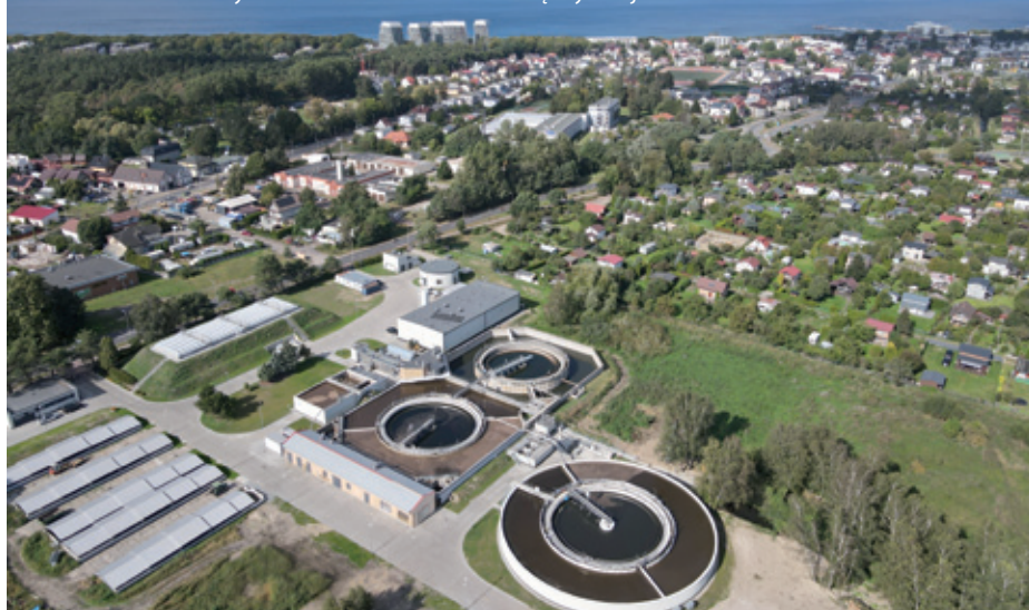
Zmodernizowana oczyszczalnia ścieków. Fot. UM Międzyzdroje
