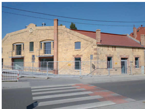
▲ Stara suszarnia cegieł adaptowana jest na Centrum Promocyjne Geoparku Łuk Mużakowa. Wartość projektu – 4,3 mln zł, dofinansowanie z RPO Lubuskie 2020 wynosi 3 mln zł, pozostała część środków pochodzi z budżetu gminy Łęknica. Centrum będzie służyło do obsługi ruchu turystycznego i promocji Światowego Geoparku UNESCO Łuk Mużakowa.
